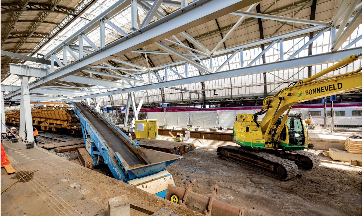
De wagons worden gevuld via een transportband.
