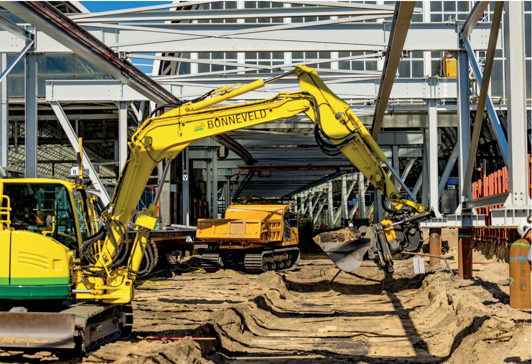
In het werkvak rijden de rupsdumpers en rupskranen van Bonneveld op en neer.
